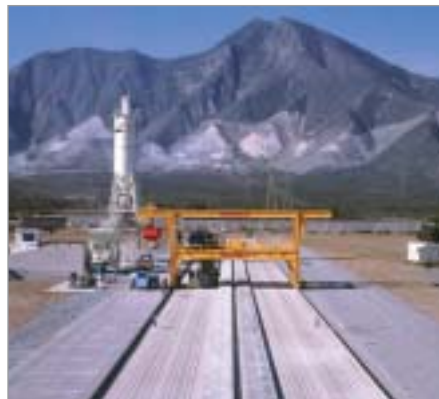
Maquinaria para varias pistas de 1,2 y 2,4 metros en Monterrey, Constructora Moyeda
